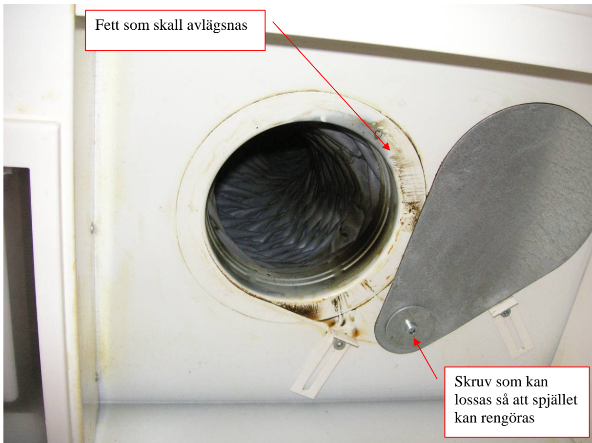
Figur 3 Spjället(metallskivan) är öppet.
